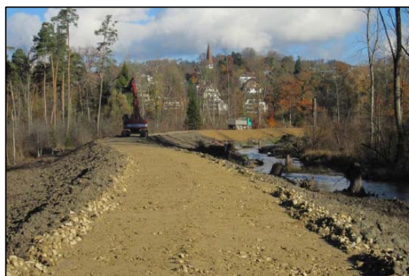
Neuer Giessenlauf und grosser Aaredamm; die Aare wird auf dem Foto links vom Damm im Zopfen mäandrieren können; Herbst 2014
